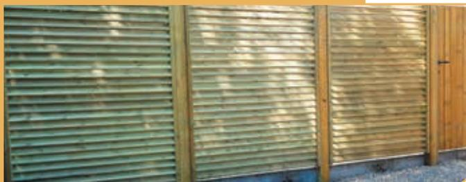
Assemblage de planchettes 16/90 entre des montants de 37/90. Préassemblées en atelier.
