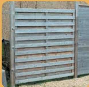
Planches de 9 mm x 90 mm clouées sur des lattes de 22 mm x 70 mm
