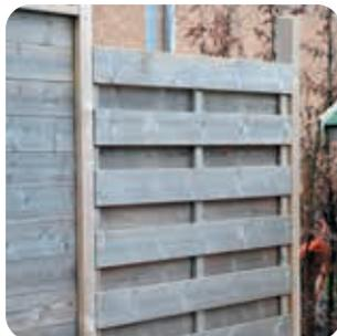
Planches de 22 mm x 140 mm clouées sur des lattes de 22 mm x 70 mm
